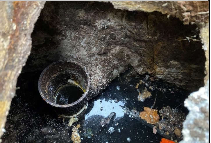
10. Outlet baffle
